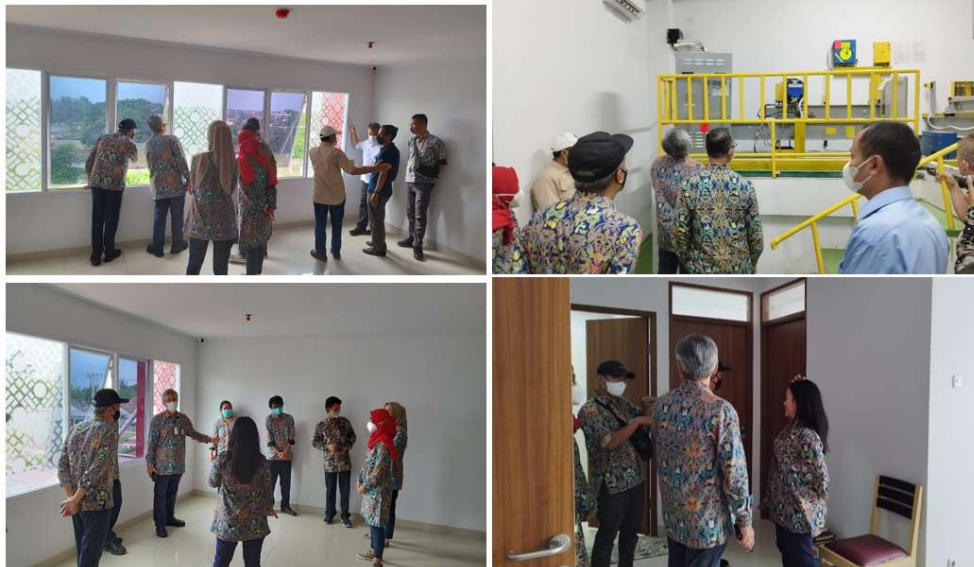
Foto. IV.2 Audit PBJ Tahap Konstruksi pada Pekerjaan Pemasangan Bored Pile pada Satuan Kerja Penyediaan Perumahan Provinsi Banten
